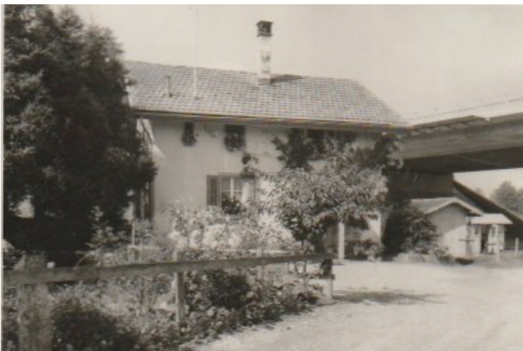
Bahnwärterhaus im Langfeld, Gossau – «Langfeldhüsli»
