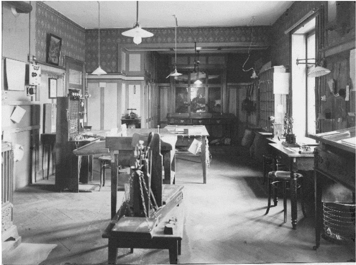
Vergleichbare Poststelle um 1900 - Hombrechtikon um 1900, Raum und die Telefonanlage Quelle: PTT-Archiv, Köniz
